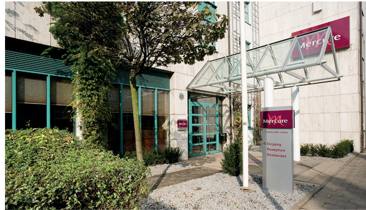
INGANGSBEREICH MERCURE HOTEL
